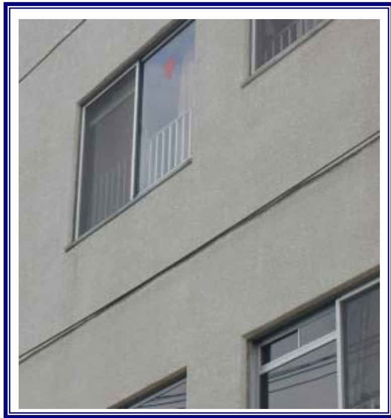
部位 : 外壁東面
