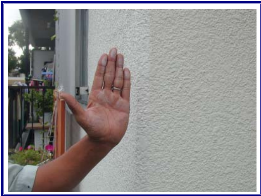
部位 : 外壁東面
