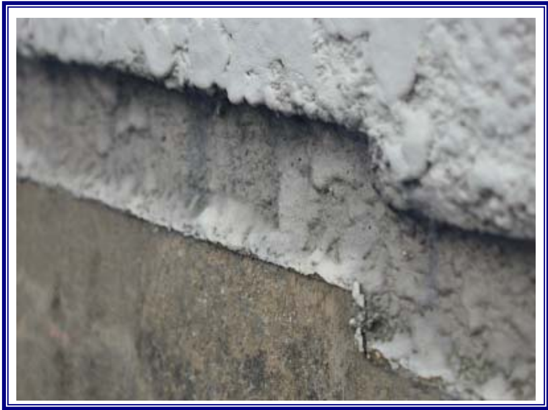
部位 : 外壁立上りシーリング
