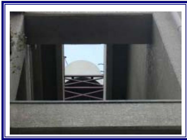
部位 : 高架水槽架台
