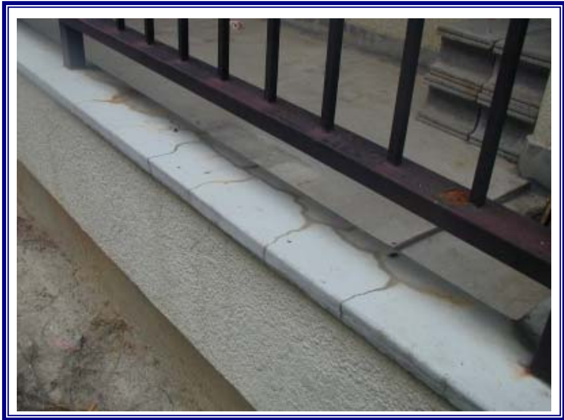
部位 : バルコニー金属手摺り
