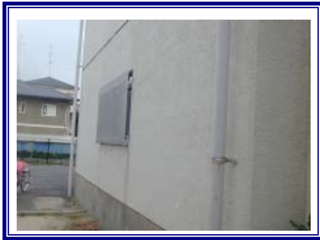
部位 : 外壁北面
